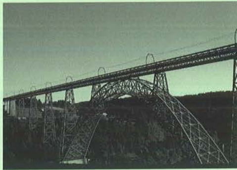
spoorwegviaduct Garabit (Frankrijk)
