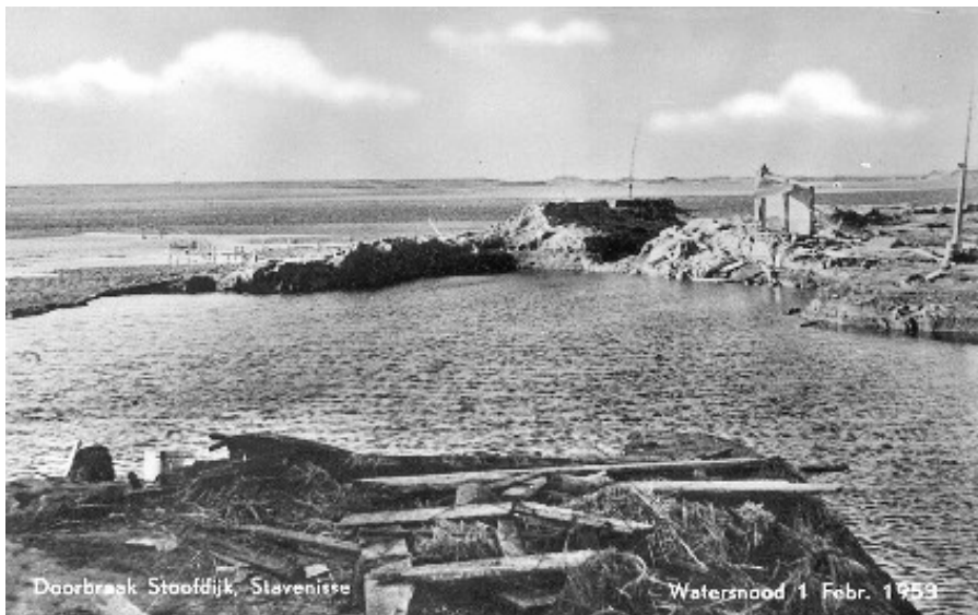
De Stoofdijk in Stavenisse, na de dijkdoorbraak, op 1 februari 1953.
